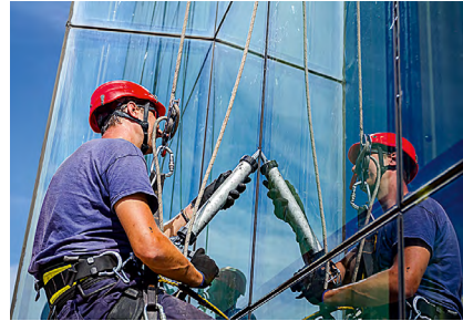
Bild 2: Auch S1-Klebung gemäß DIN 2304 werden manuell durchgeführt (Bild: AdobeStock_ Roman_23203)
